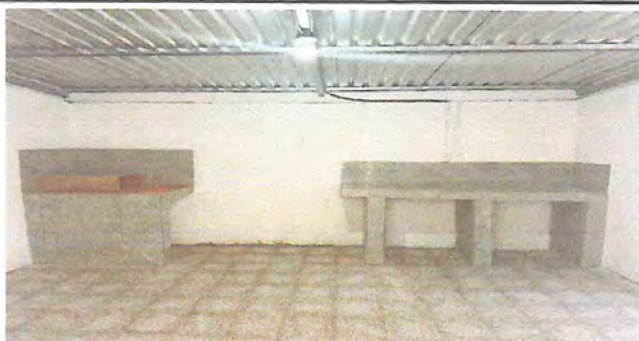
Foto1: Mejoramiento de la cocina de la escuela. Elaboración de hornilla, mesa fundida y sustitución del piso.
