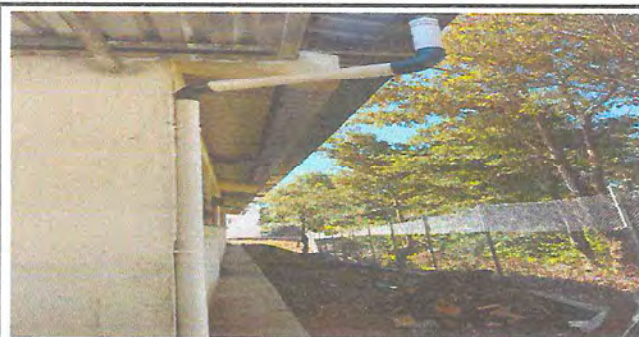
Foto 5: Canales y bajadas fluviales en la parte de atrás de la escuela
