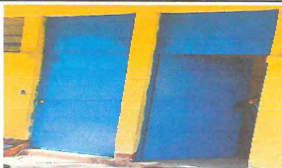
Foto 5: Sustitución de puertas
