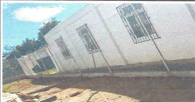
Foto1: Sustrucción de cerco perimetral por muro perimetral, block y malla de 2 metros de altura.
